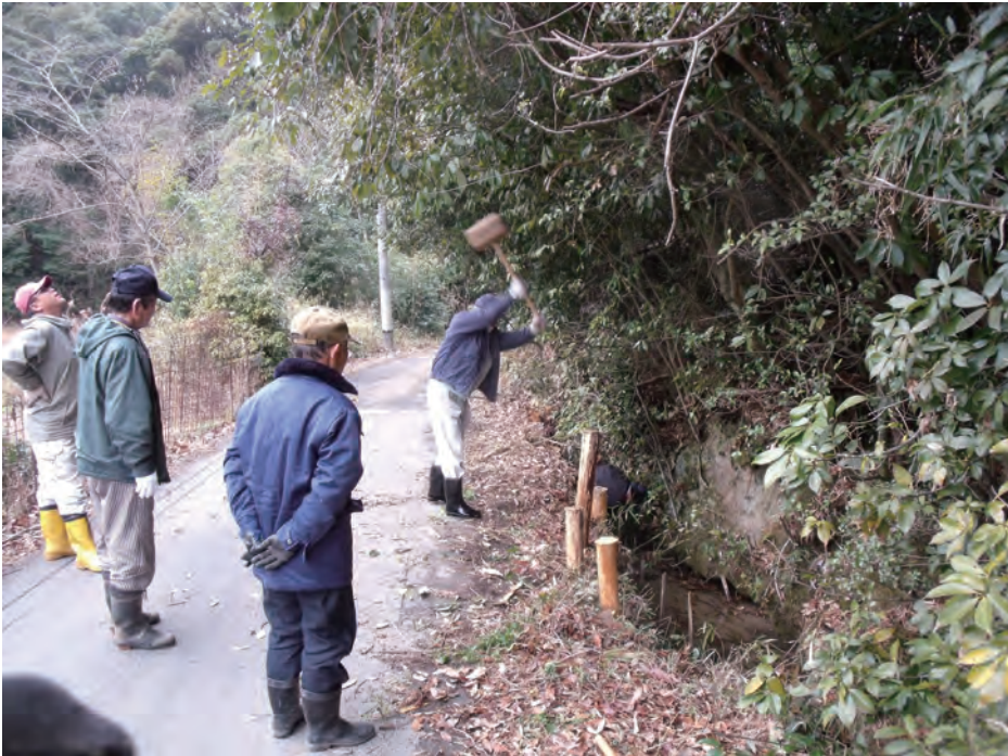
陥没対策の杭打ち
