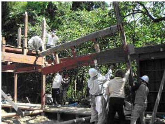
ボランティアのチカラで順調に解体されていく
