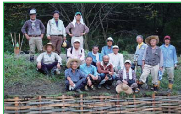
ため池の修景工事
